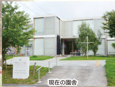
建物の右半分が、開園時の保育園でした
